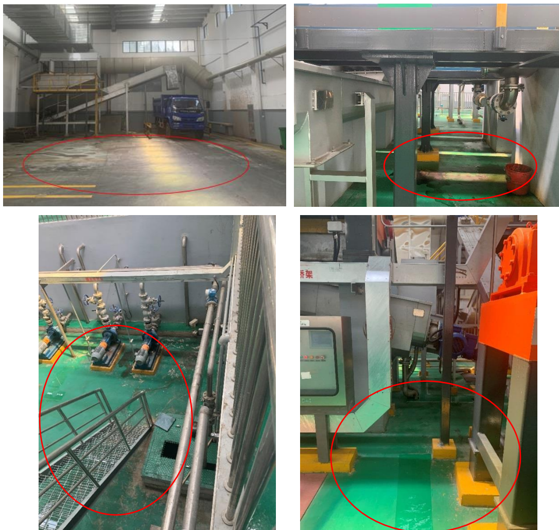
图 4.6-1 车间防腐、防渗措施
