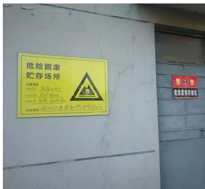
图4.1-13 危险废物贮存场所标识标牌
