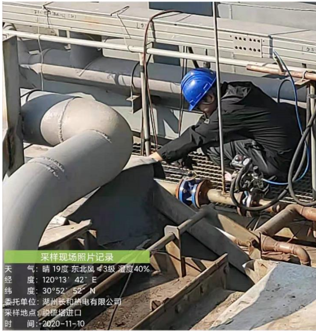
图 7.1-2 脱硫塔进出口采样
