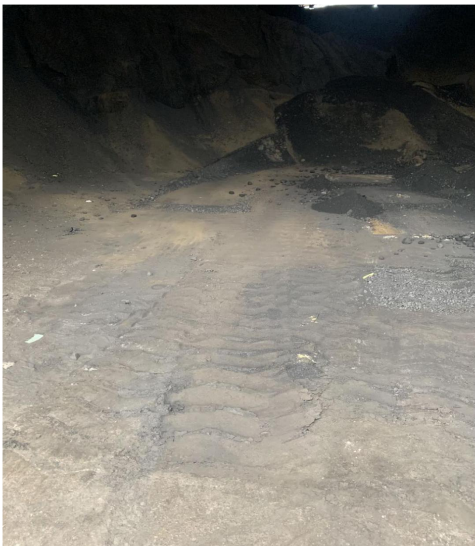
图4.1-20 煤库地面硬化
