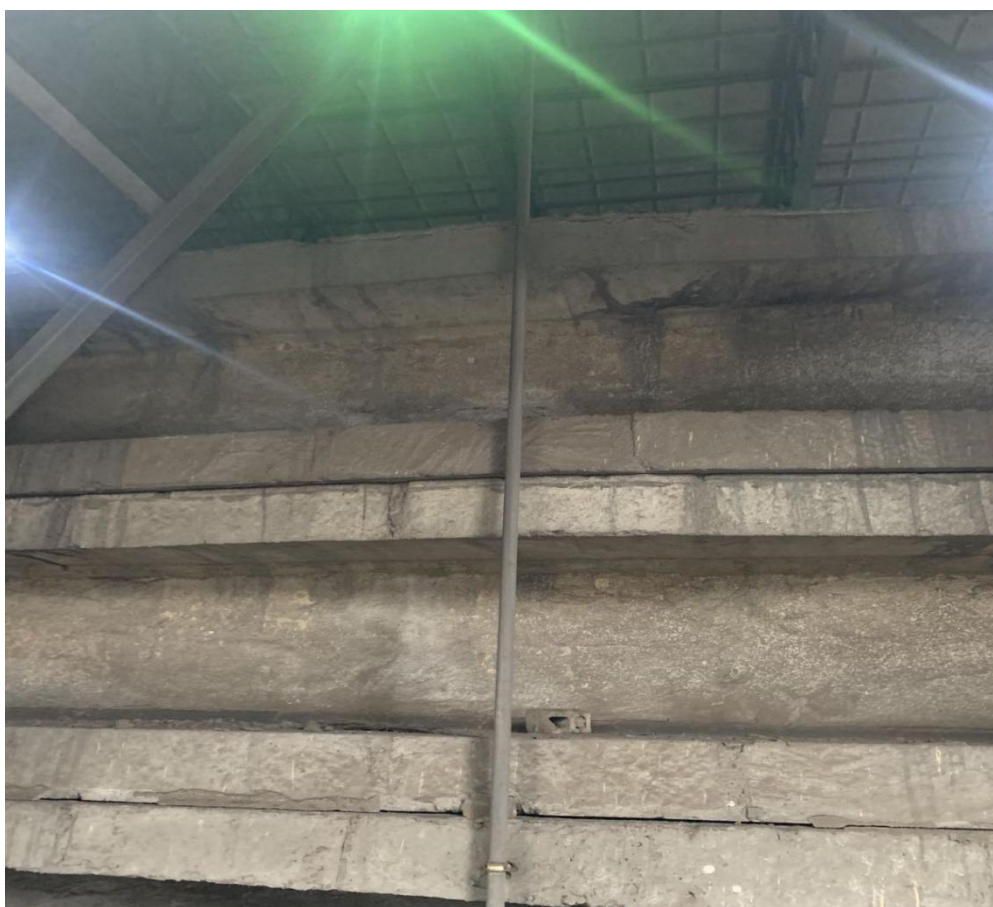
图4.1-10 脱硫废水喷淋管道
