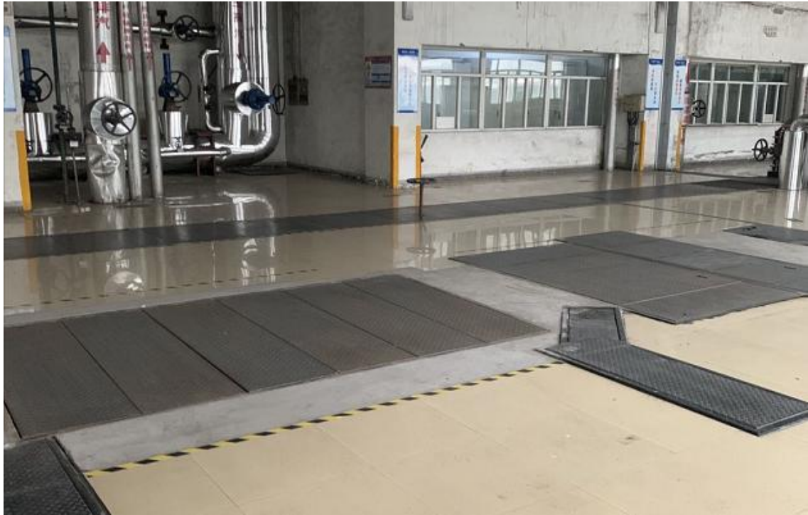
图 3.3-3 原 1#发电机组所在位置（已拆除）
