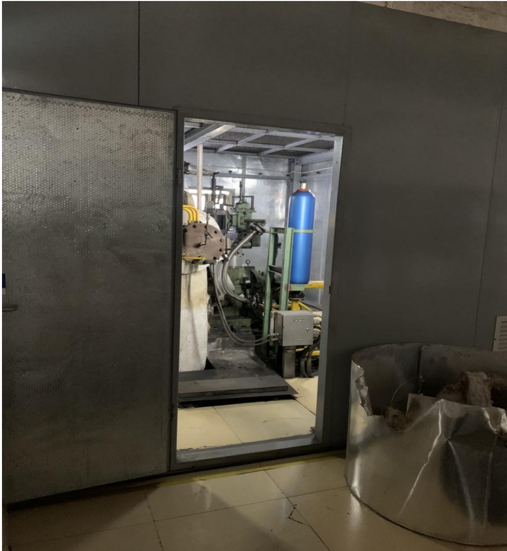
图4.1-18 原有汽机发电机组隔声罩
