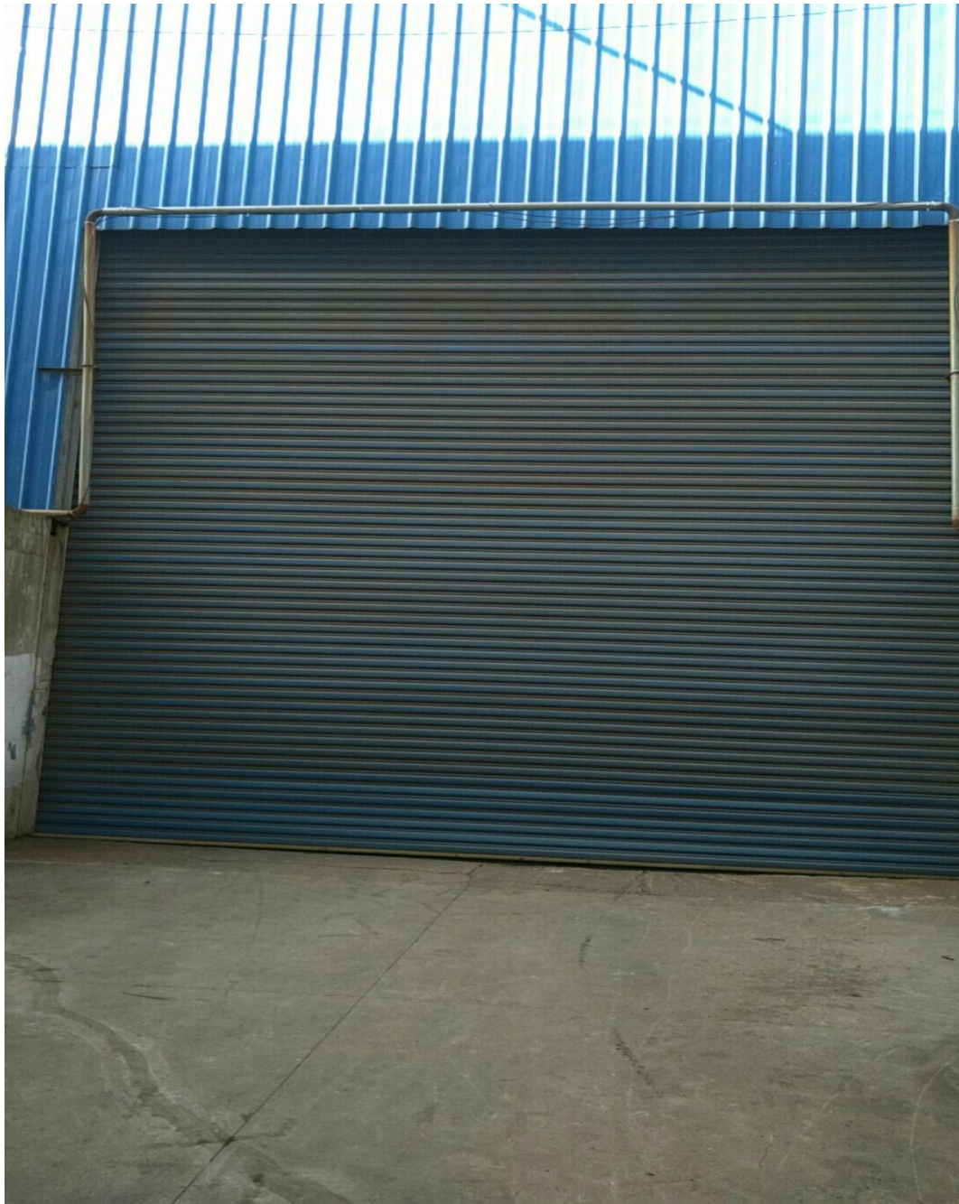
图4.1-7 封闭煤场卷帘门
