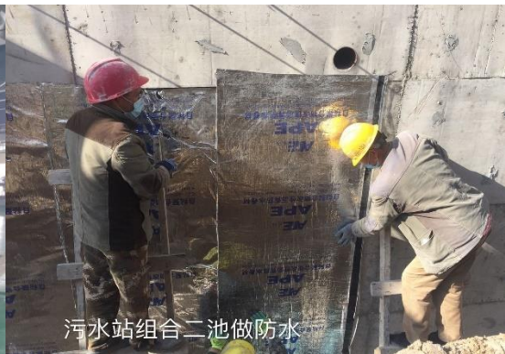
图 10.1-13 污水站防渗施工
