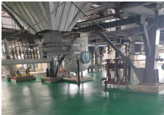
图 10.1-12 焚烧车间防渗层
