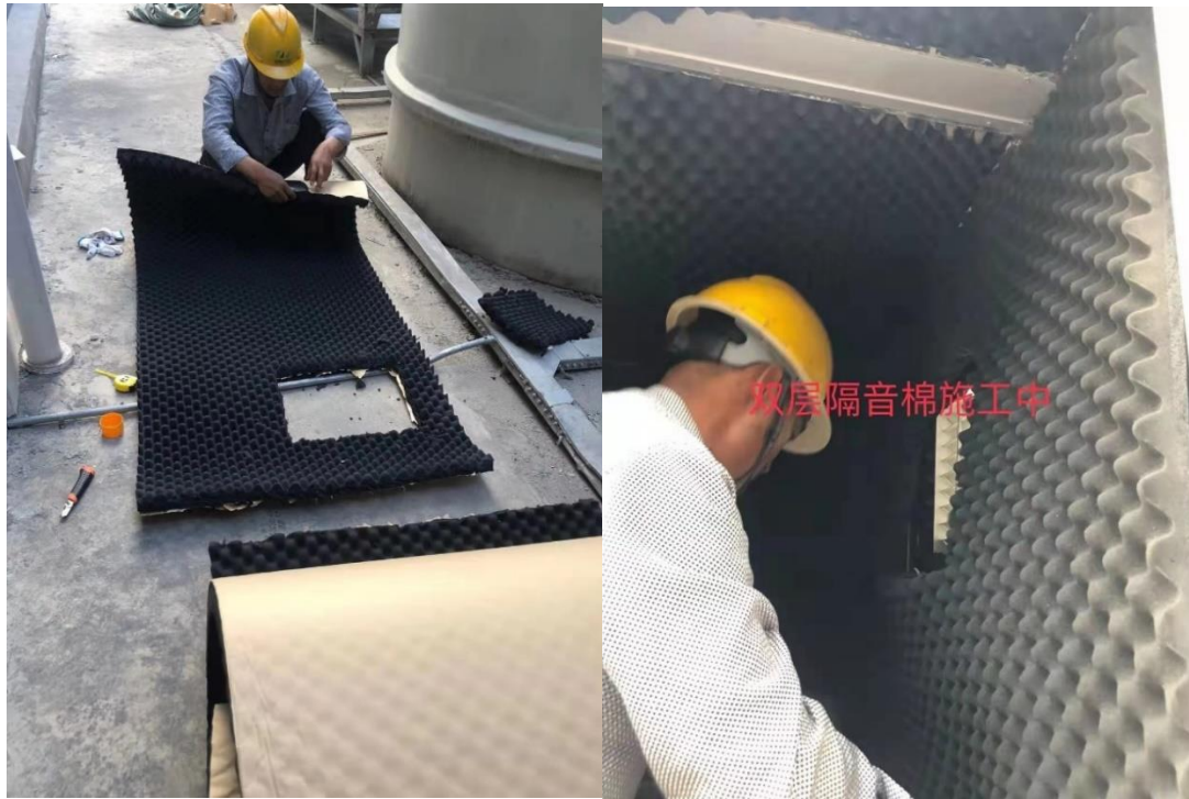
图 9.5-1 双层隔音棉安装图
