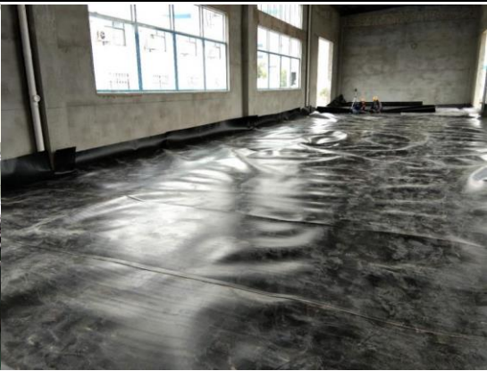
图 10.1-11 危废暂存间防渗层施工
