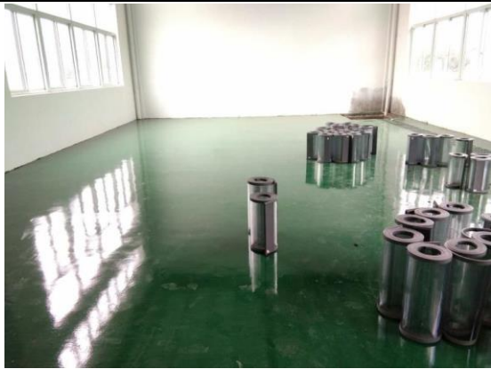
图 10.1-10 灰渣库防渗地坪
