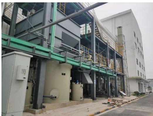
图 4.1-11 三效蒸发装置
