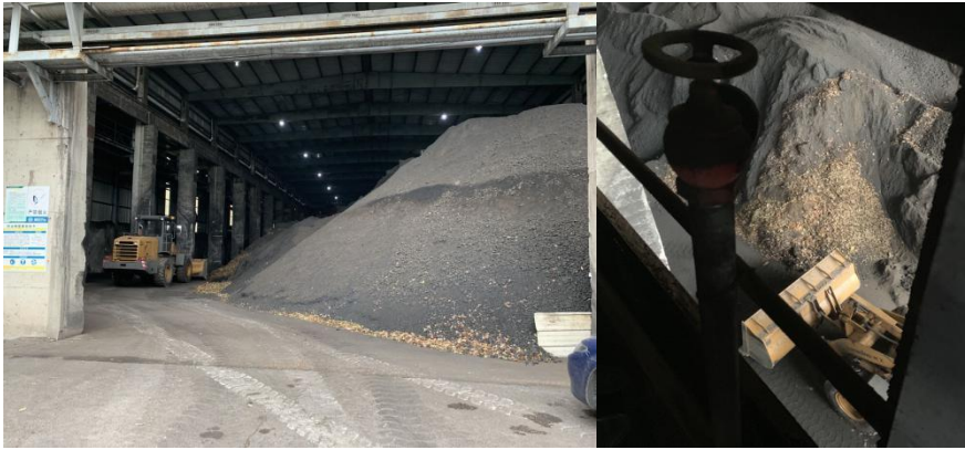
图 3.1-1 煤库地面硬化，安装大门封闭，已设置喷淋
