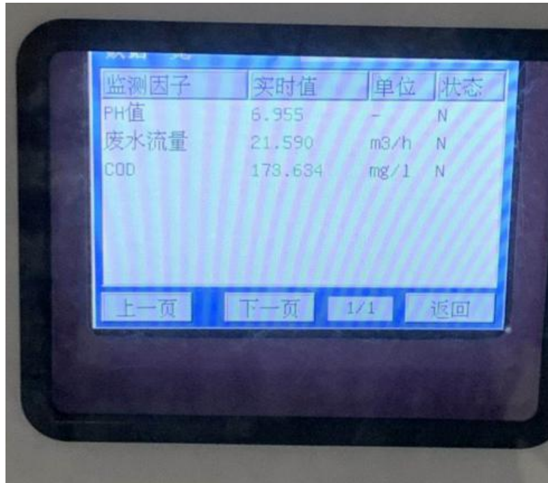
图 4.1-4 污水在线监测系统显示屏
