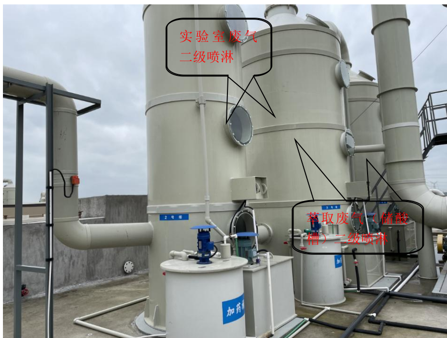
本项目萃取废气（储酸槽）、实验室废气二级喷淋吸收塔（碱液喷淋）
