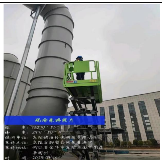
14#: 危险废物暂存间装置进口
