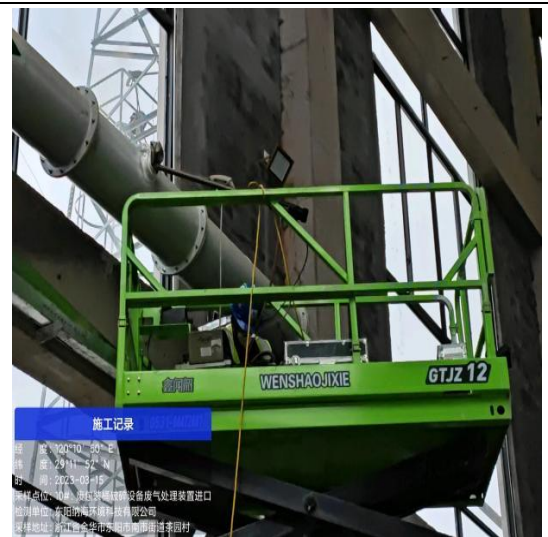
10#: 废包装桶破碎车间废气处理装置进口
