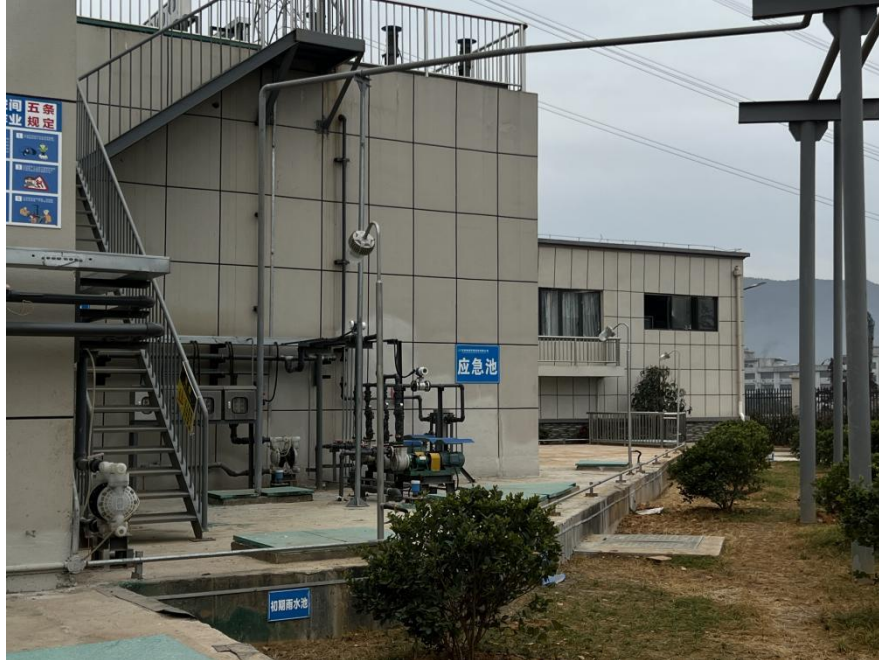
图 4.2-1 事故应急池和初期雨水收集池
