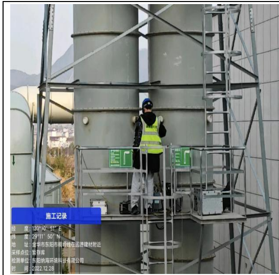
15#: 危险废物暂存间装置出口
