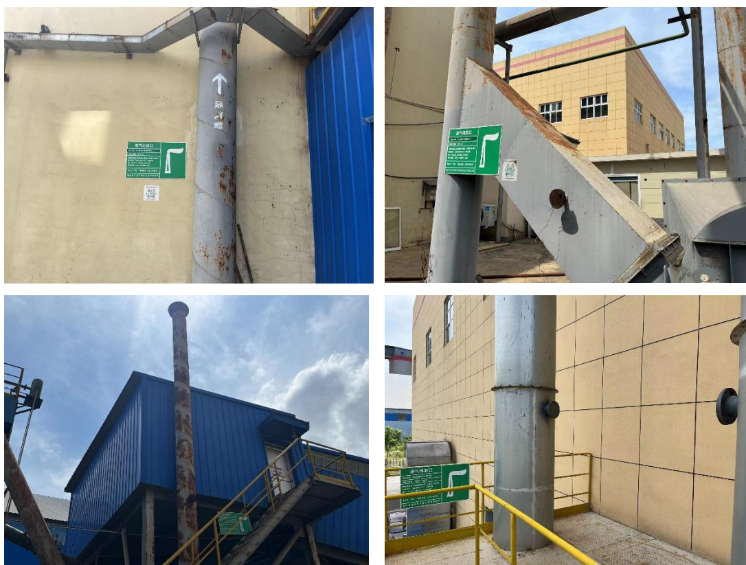
图 4.1-6 废气排放口标识标牌
