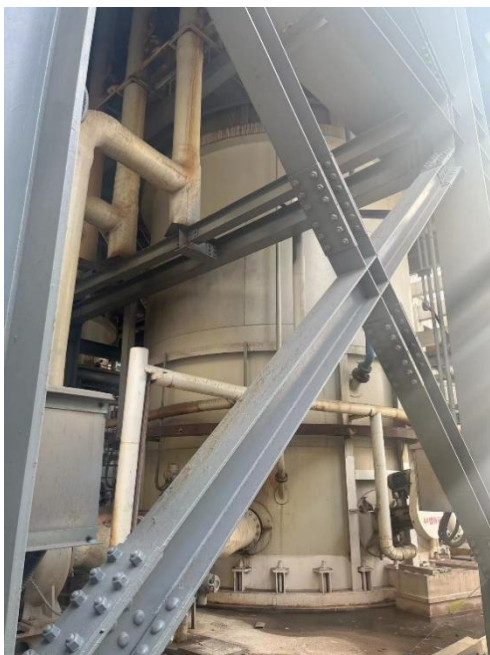
图 3.1-3 脱硫装置
