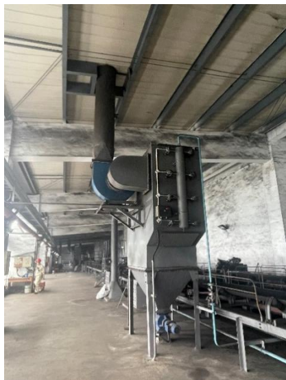
图 3.1-5 2#炉前料仓布袋除尘装置
